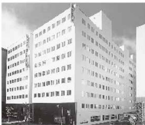
北海道通信ビル・第二北海道通信ビル(中央区北5条西6丁目)
