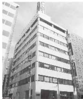
第五北海道通信ビル（北区北7条西4丁目）
